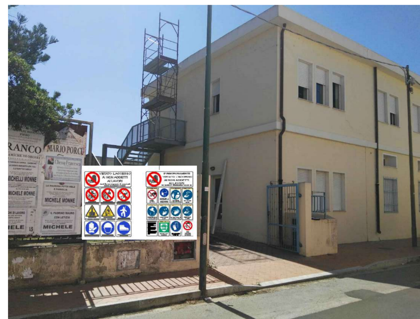
VISTA DELL'INGRESSO AL CANTIERE
