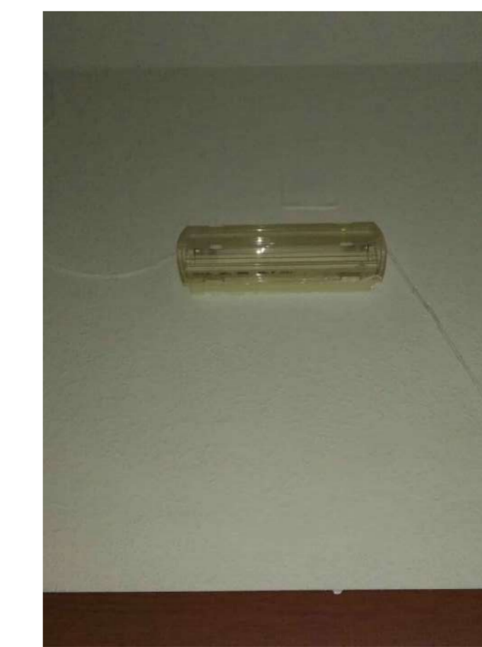
Illuminazione di sicurezza
