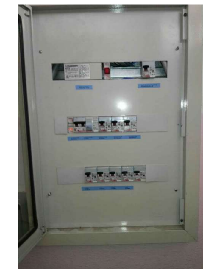
Quadro elettrico generale
