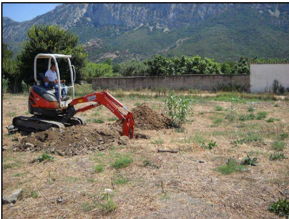
Figura 9 - Esecuzione dei pozzetti geognostici attraverso un escavatore meccanico.
